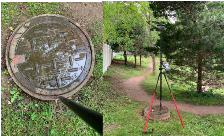
不安定な環境で通常機材利用は作業的に非効率的な状態
